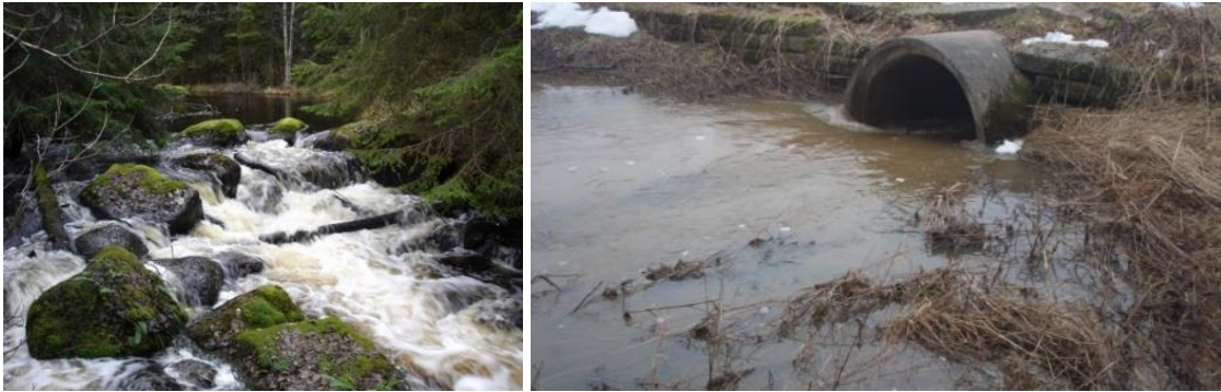
Figur 5-13. Exempel på bestämmande sektioner i vattendrag. Till vänster en fallsträcka nedströms ett flackt vattendragsområde. Fallsträckan har avgörande betydelse för vattennivåer och morfologi i området uppströms. Till höger en vägtrumma som vid biotopkartering klassas som bestämmande sektion, men som i strikt tolkning av begreppet bestämmande sektion ligger i en gråzon. Trumman bromsar flödet och har avgörande betydelse för vattennivå och morfologi uppströms. I just detta fall fungerar trumman som substitut för en bestämmande sektion (en strömsträcka) som har tagits bort ur det aktuella vattendraget och är därmed positiv för morfologin uppströms.
